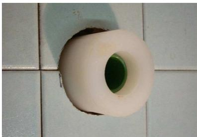
Posizione del raccordo cieco + protezione in polietilene dopo il rivestimento della parete.
