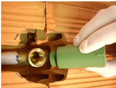
Inserire il raccordo cieco per collaudo impianto, avvitandolo fino a battuta dell'O-ring.
