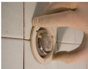
Avvitare il soffioncino fino in battuta con l'apposita chiave in dotazione, utilizzando canapa o similari per realizzare la tenuta idraulica.
