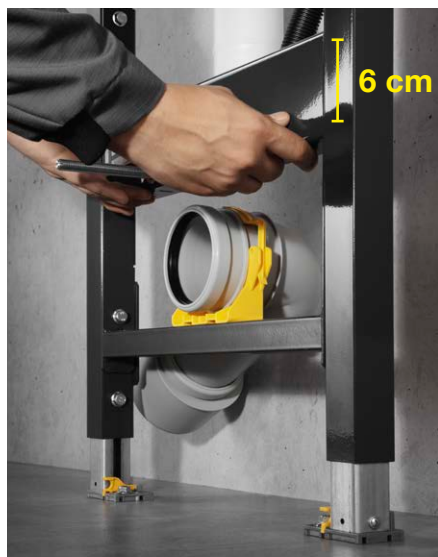
In een handomdraai te realiseren: de hoogteverstelling van 6 cm.
